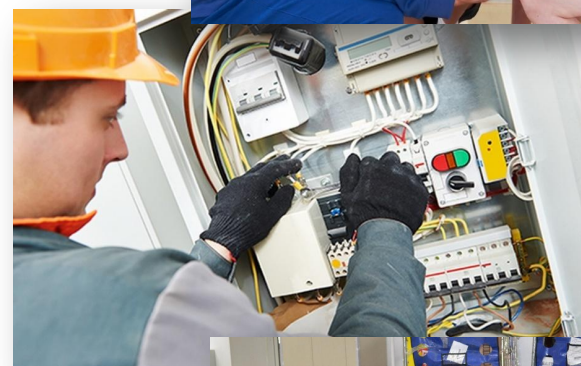
Электромонтёр по ремонту и обслуживанию электрооборудования
