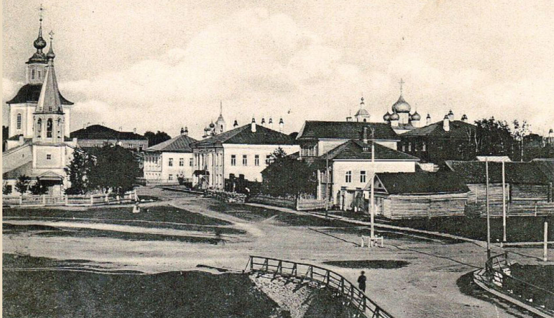
г. Вьлозерскъ. Церк. Св. Иоанна Богослова. Земская Управа.
