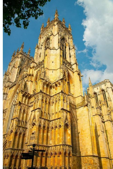
Башня Йоркского собора
