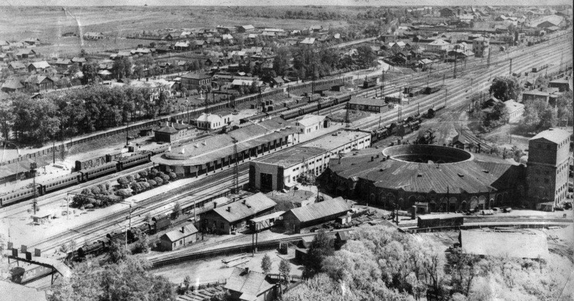
Панорама на железнодорожный узел станции Окуловка
