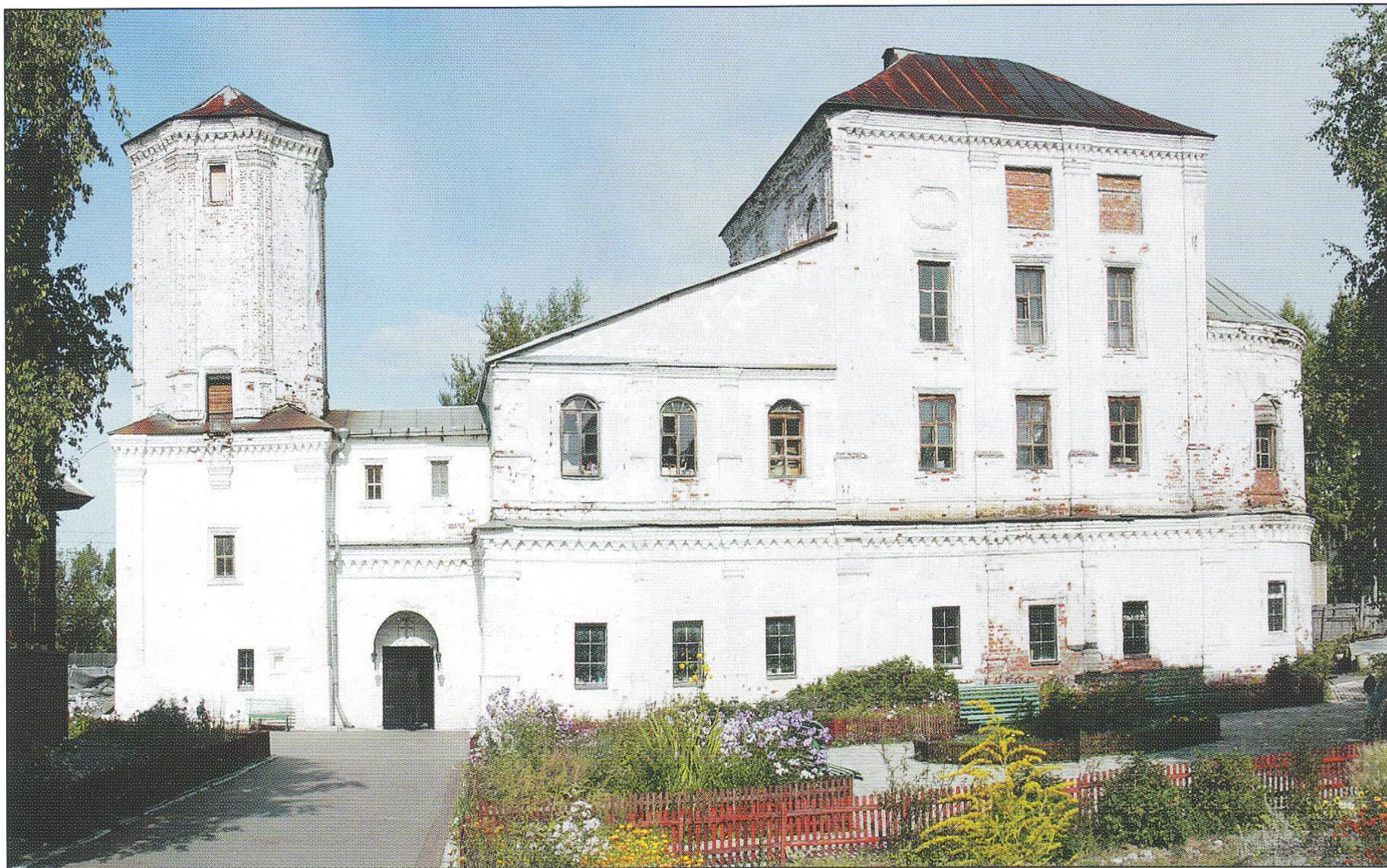
Свято-Троицкая церковь. Южный фасад.
