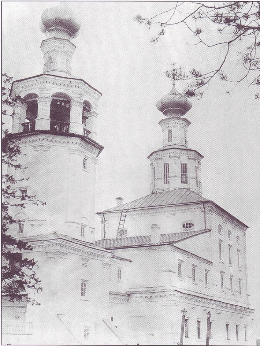
Свято-Троицкая церковь Вид с юго-запада.
