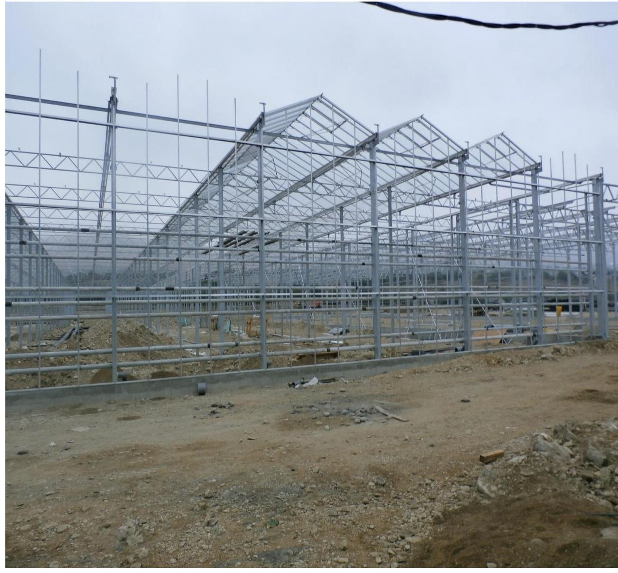
После монтажа конструкций и остекления , начался монтаж оборудования : установка и наладка метео станции
