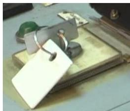
**На механизмах с электроприводом, разборка силовых цепей и цепей управления которых возложена на оператора, имеющего соответствующую (не ниже II) группу по электробезопасности, используется ключ с навешенной жетон–биркой, который одновременно выполняет функции ключ–бирки и жетон-бирки.**
