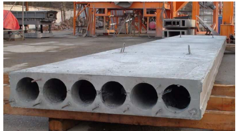
Рис. Пустотная плита
