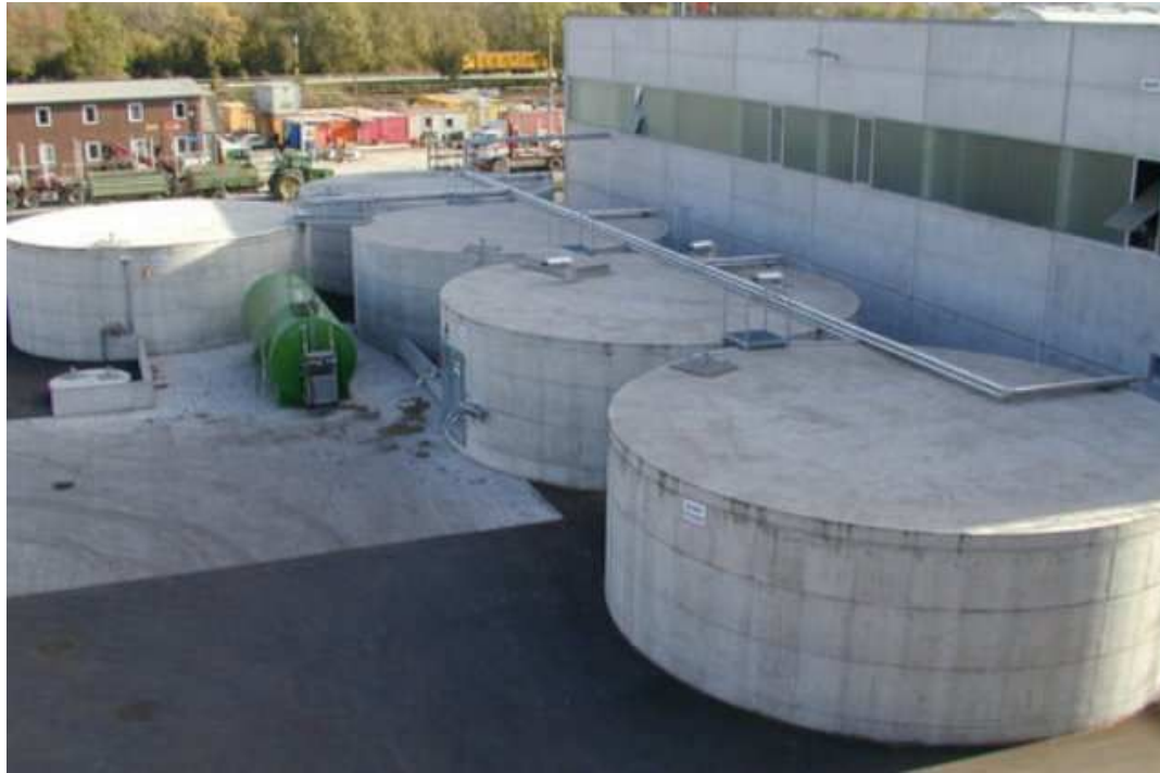
Рис. Пожарные резервуары из железобетона
