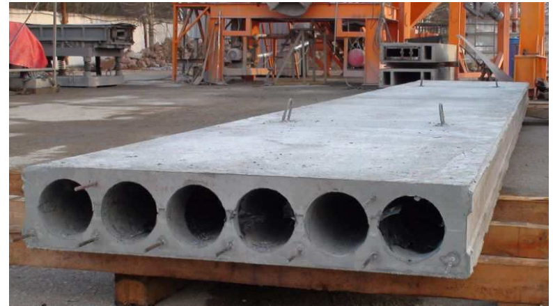
Рис. Пустотная плита
