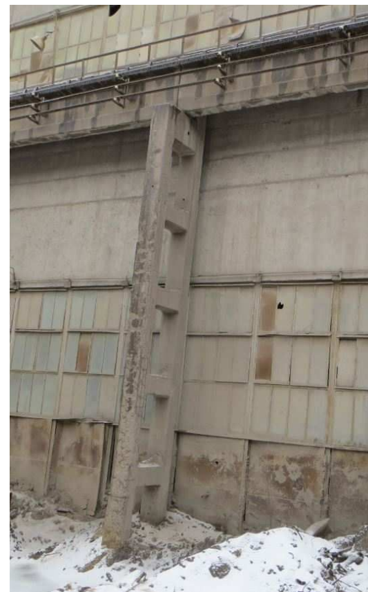
Рис. Сборная железобетонная колонна крановой эстакады
