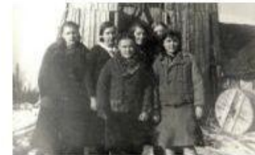
Женская бригада кочегарки буровой скважины № 8. Октябрь 1941 г. НАРК. Ф. Р-1010. Оп.2. Д.4234
