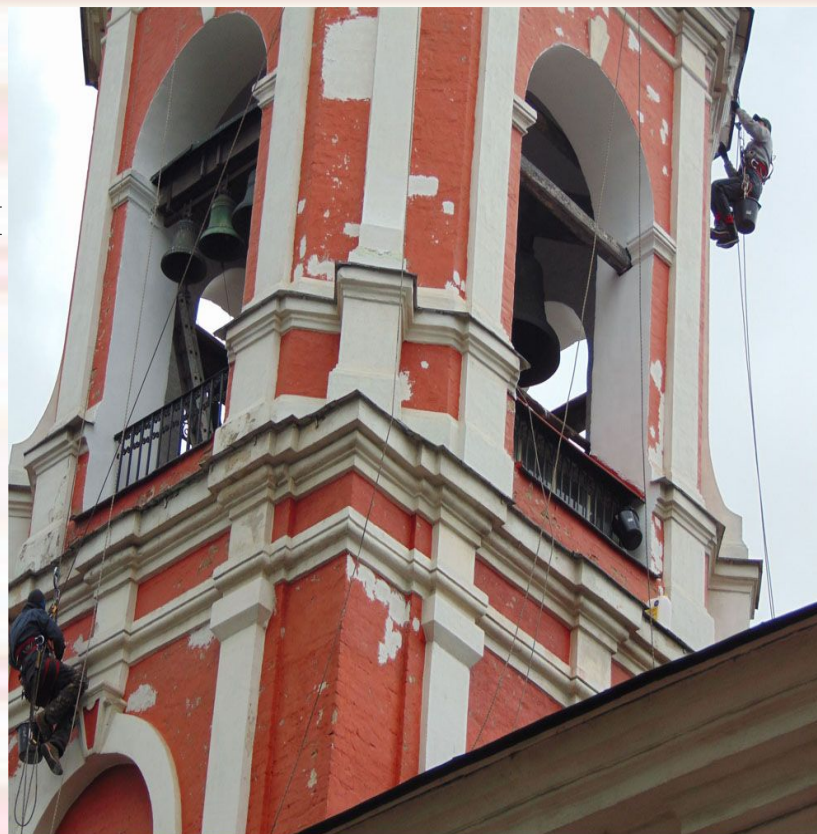
Покраска фасада Храма © StroyAlp.ru
