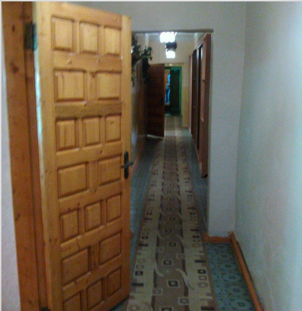
допущено применение горючих материалов на путях эвакуации для отделки пола и стен в помещениях
