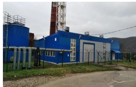
26 котельная , г Геленджик, ул.Горная,29а
