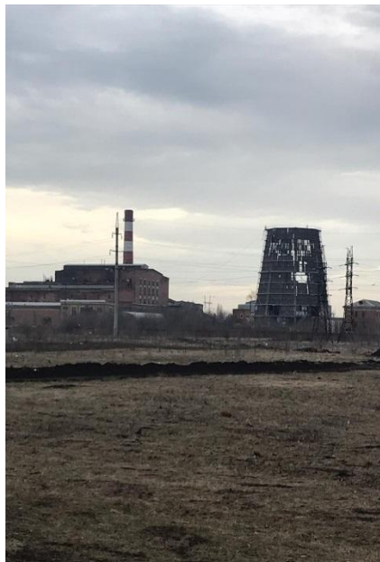
Армавирская ТЭЦ (выведена из эксплуатации)
