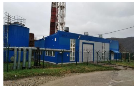
26 котельная , г Геленджик, ул.Горная,29а
