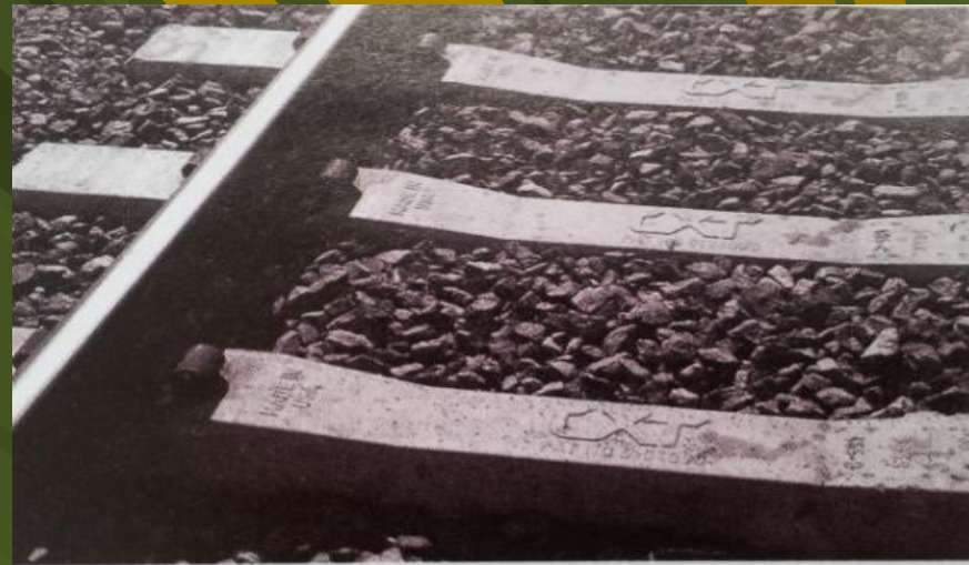
Рис. 1. Путь на железобетонных шпалах компании СХТ
