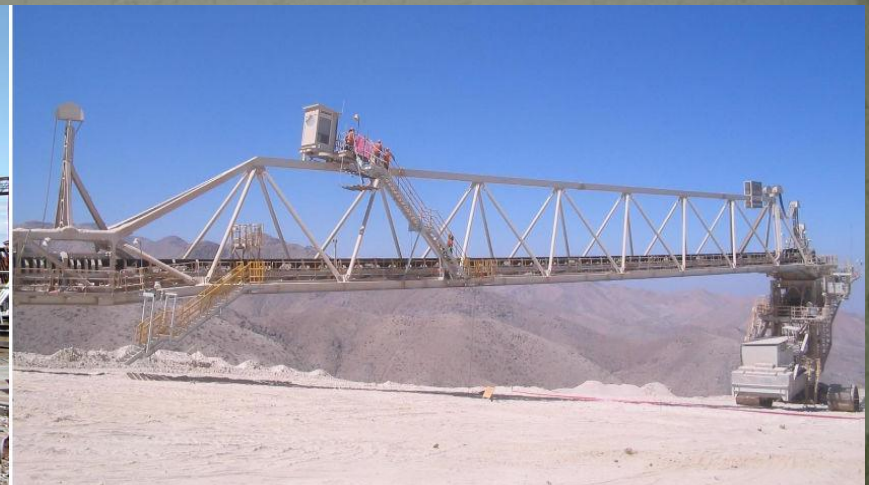
Другие виды конструкций(отвальные мосты)
