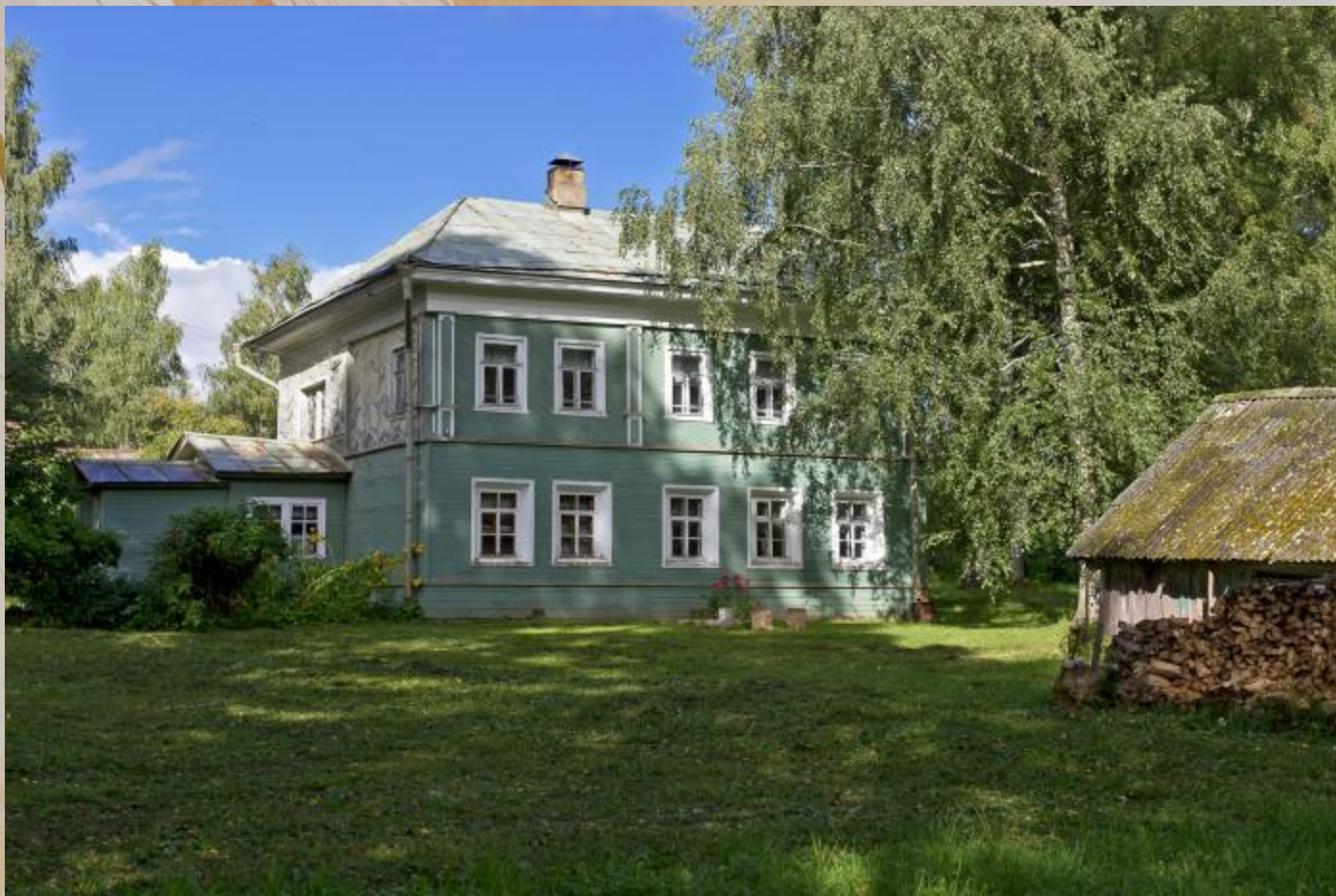
Двухэтажное здание школы в селе Абакумцево (в четырёх километрах от Грешнева).
