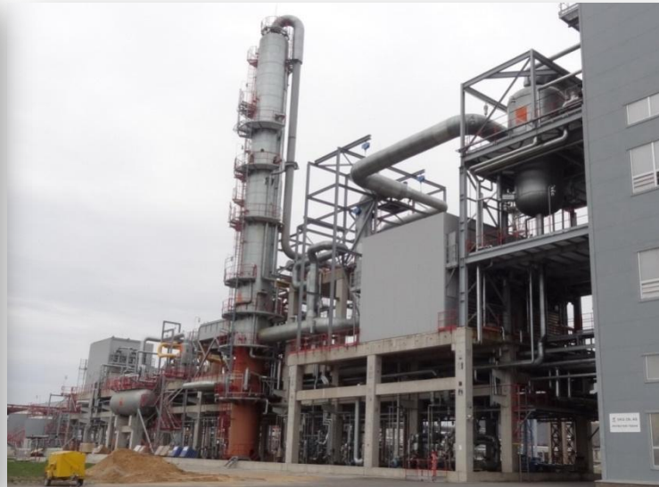
Отделение конденсации на УТТ-3000 в Кохтла- Ярве (в центре)
