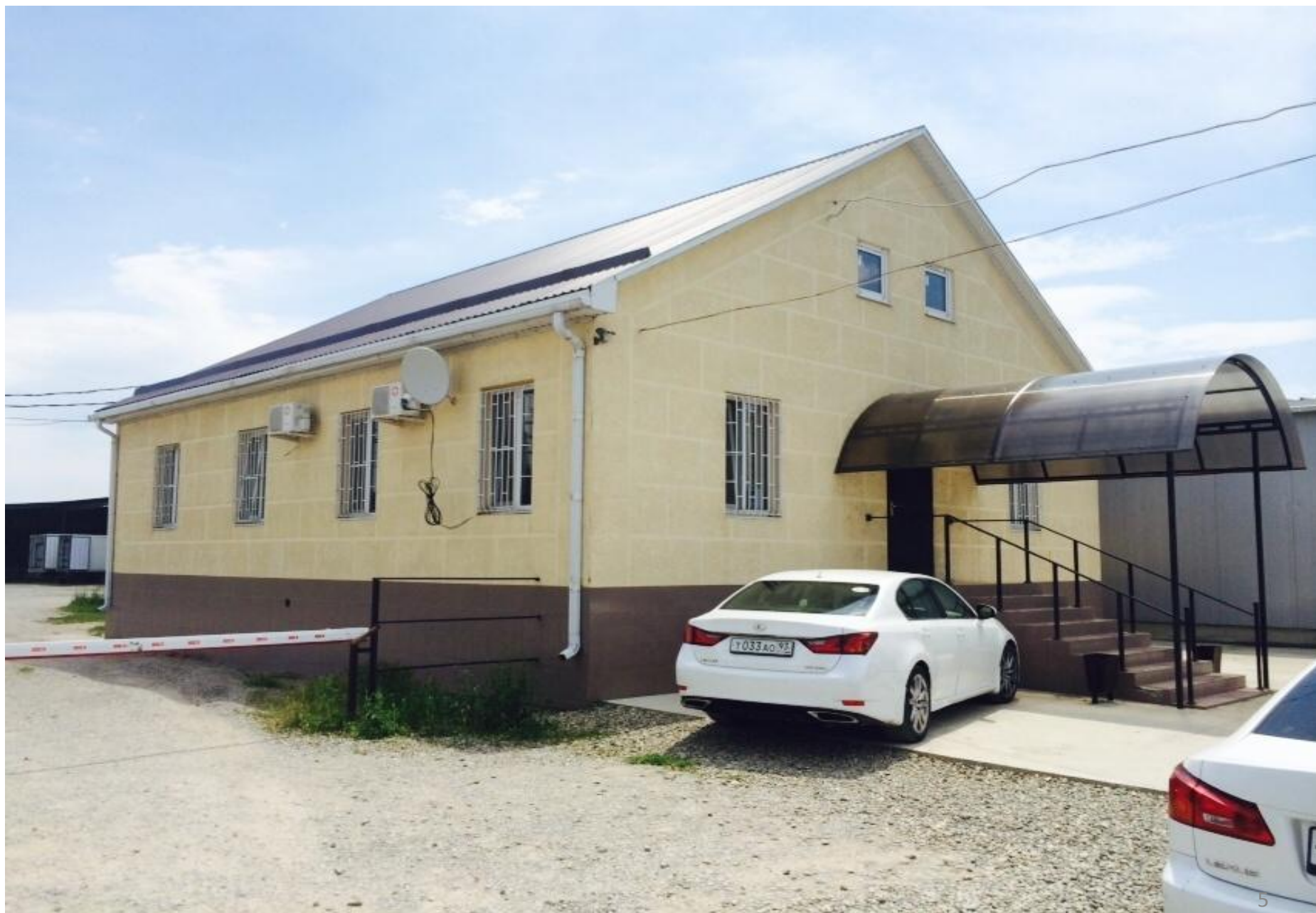
Офисное здание (кабинетная система) цоколь + 1 этаж, общая площадь 233,3 кв. м.
