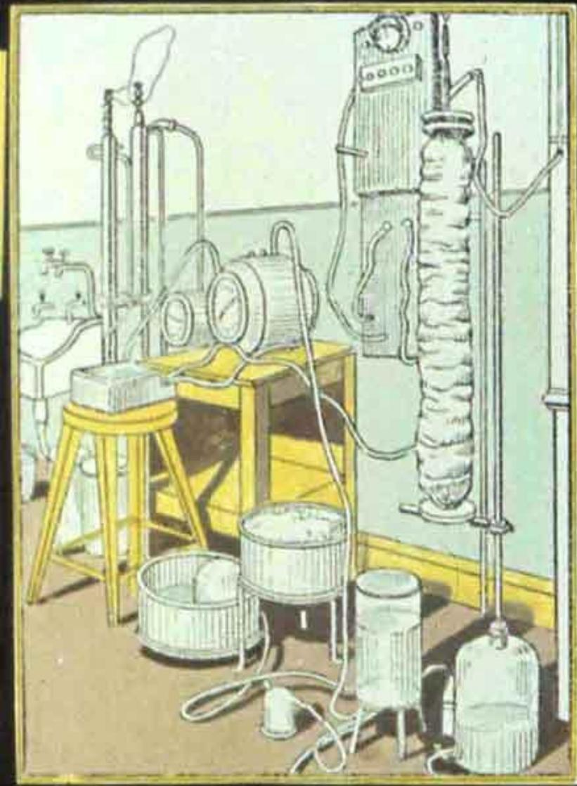
Первая опытная лабораторная установка для получения бутадиена из спирта.
