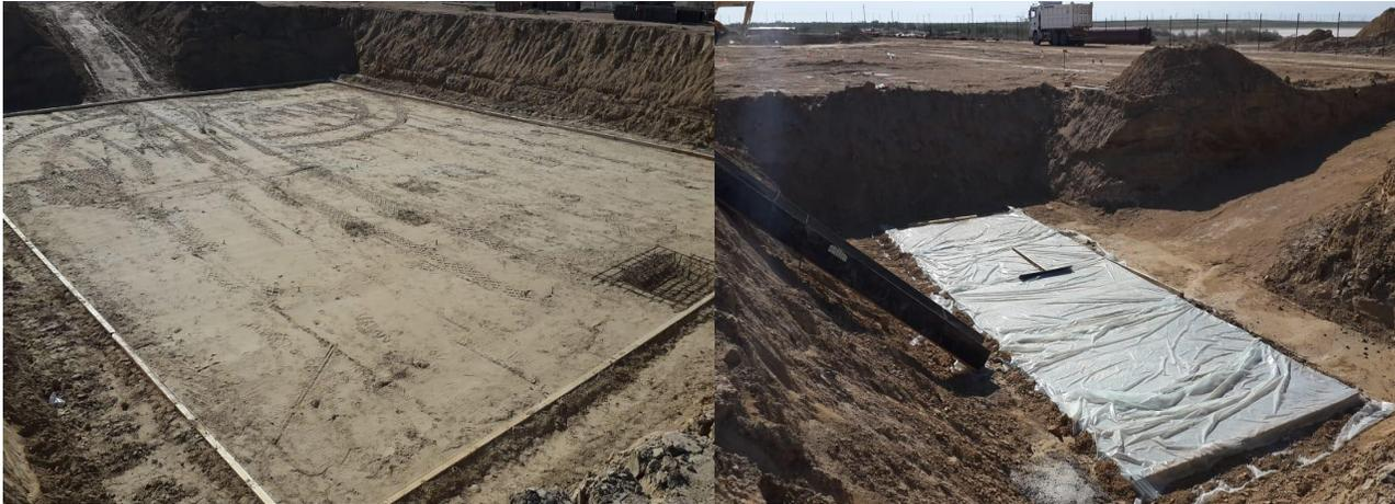
Ведутся работы по устройству ЖБИ резервуаров, строительство узлов учета. Подготовка фундаментов под насосные станции, площадка камеры запуска скребка.
