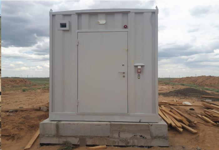
В линейной части ведутся работы по устройству фундаментов под блок боксы и опоры для подвода электричества.
