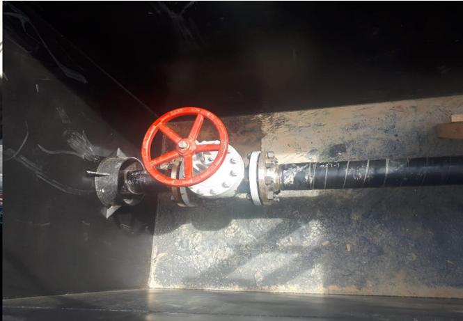
Проводятся работы на линейных и корневых колодцах по установке запорной арматуры.
