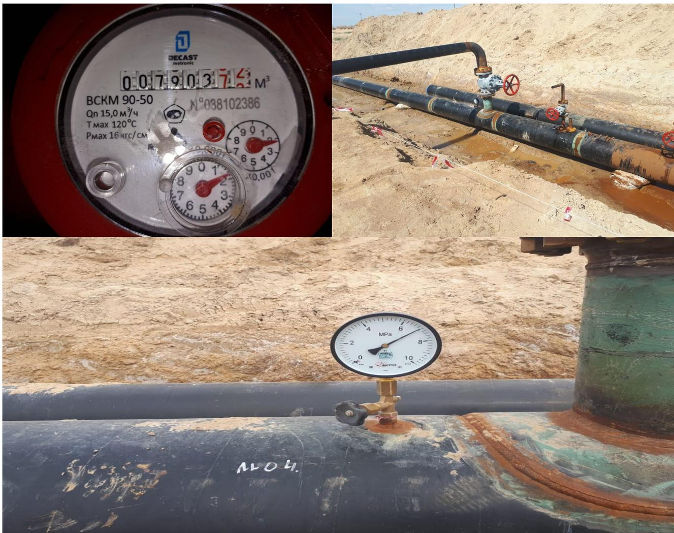
Работы по очистке полости трубы,заполнение и гидротест.
