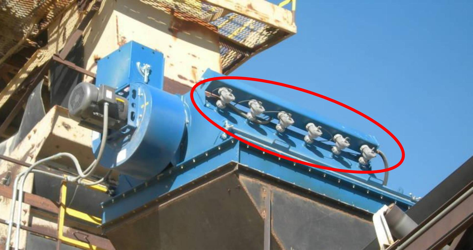
Удаленное реле времени открывает электромагнитный клапан каждой группы фильтров на заданный период времени. Поочередное приведение в действие электромагнитных клапанов позволяет поддерживать работу пылеуловителей, переключая на другие ряды рукавов, не задействованные в
