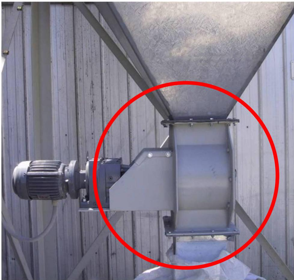
Если дозатор не будет герметично закрыт, разрешение внутри отсека рукавных фильтров исчезнет и фильтрация не произойдет.
