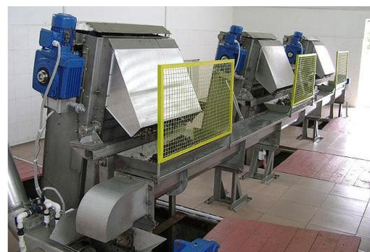
Размер решеток определяется из условия обеспечения в прозорах решеток оптимальной скорости 0,8–1,0 м/с при максимальном расходе сточных вод.
