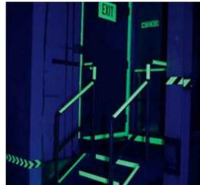
Использование фотолюминесцентной сигнальной разметки на пути движения в местах с плохой освещённостью
