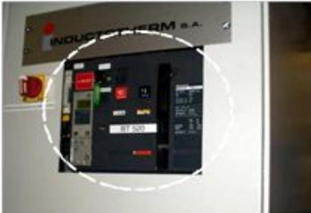
В двери сделано отверстие для возможности контроля оборудования без необходимости ее открытия
