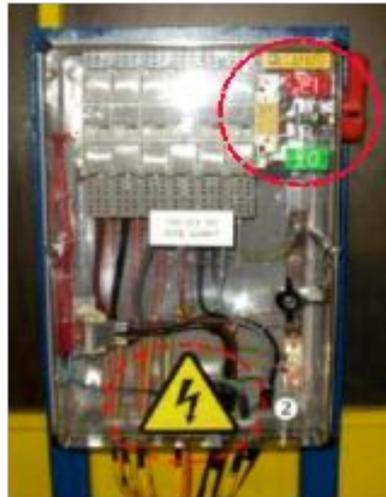
Для более легкого контроля электрического выключателя используют прозрачные крышки
