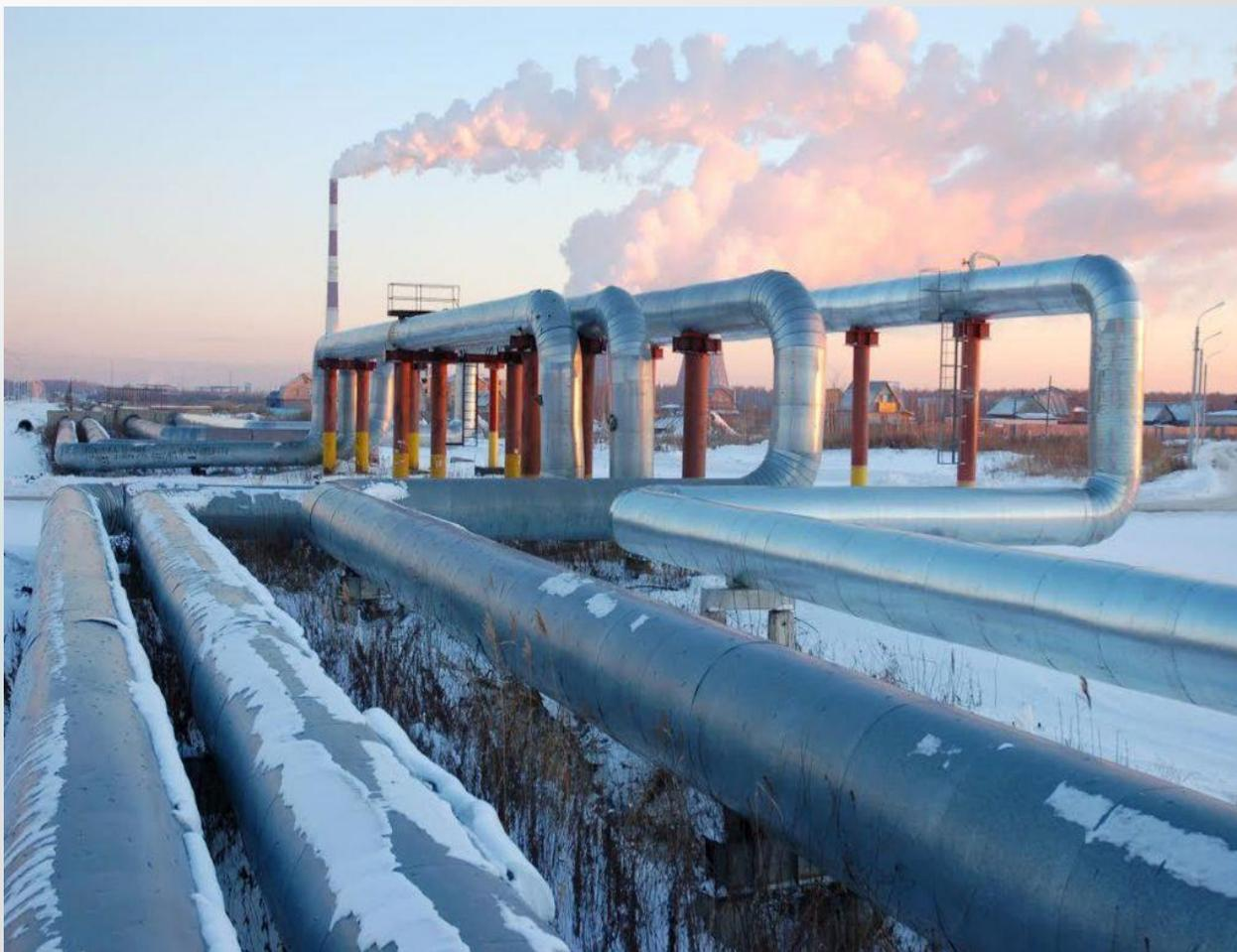
При центральном отоплении зданий источник тепла (горячая вода) также подаётся по трубам из котельной.
