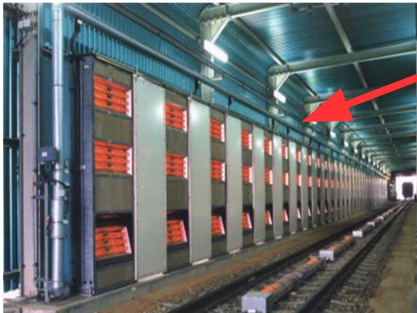
Оттаивание вагонов при помощи инфракрасных излучателей имеет смысл только при использовании опрокидывателей вагонов
