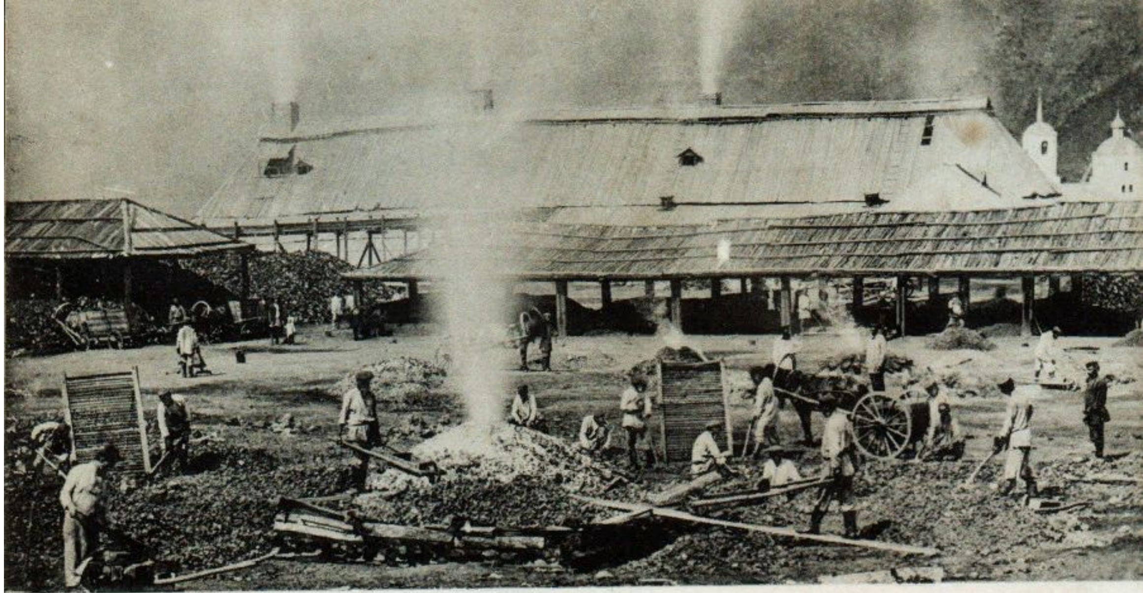
Виды и типы Нерчинской каторги.—Les galères à Nertschinsk. № 14. Ожигание серебряно-свинцовой руды.—La calcination de sang d'argent.
