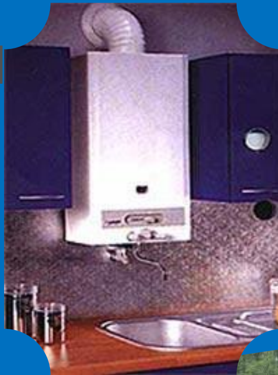
газовая колонка для подогрева воды
