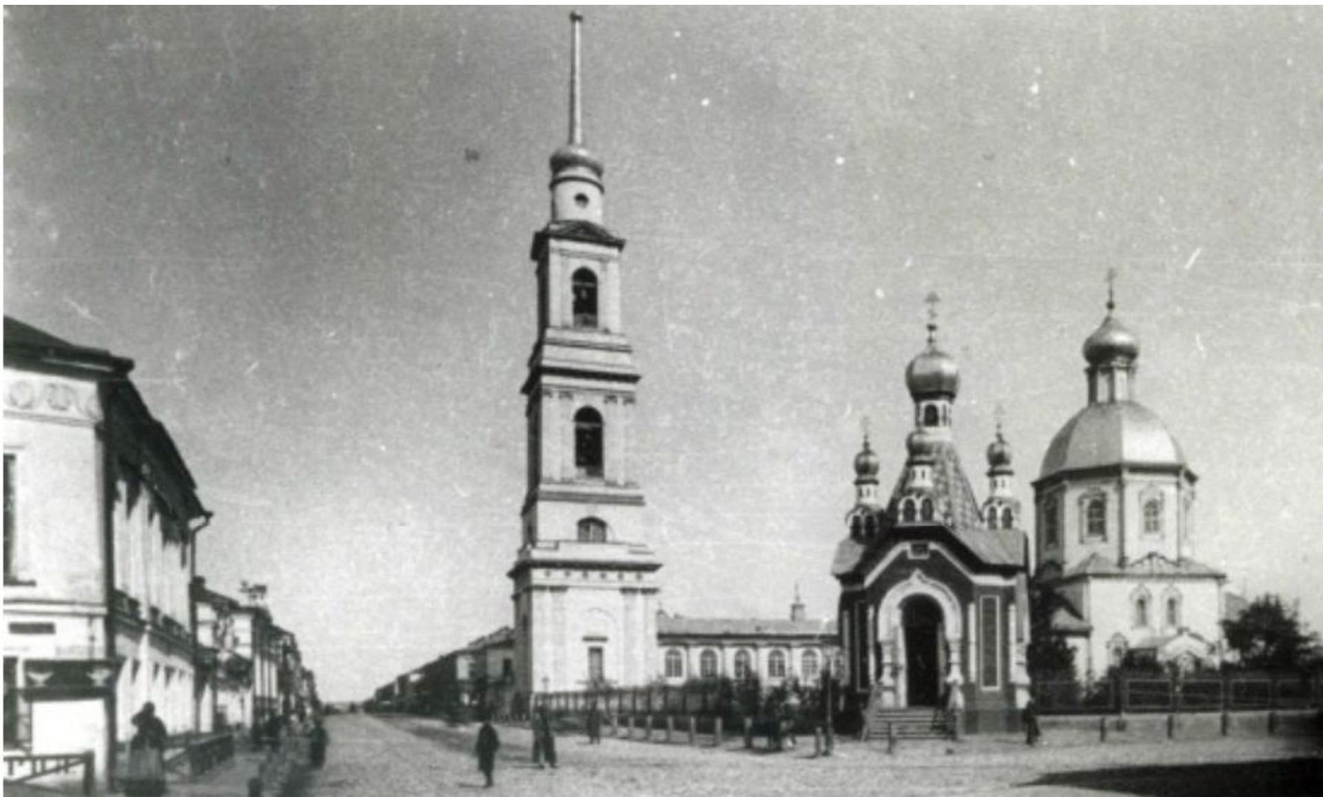
Владимирский собор строился с 1694 по 1718 годы. В 1836-1847 гг. по проекту Петонди строится колокольня
