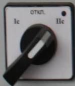
SA6 Выбор питания выходных реле защит тр-ра 2 комплект
