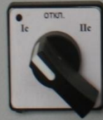
SA7 Выбор питания выходных реле защит перекидки 1 комплект
