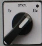
SA2 Выбор питания защит трансформатора 2 комплект
