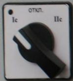
SA1 Выбор питания защит трансформатора 1 комплект
