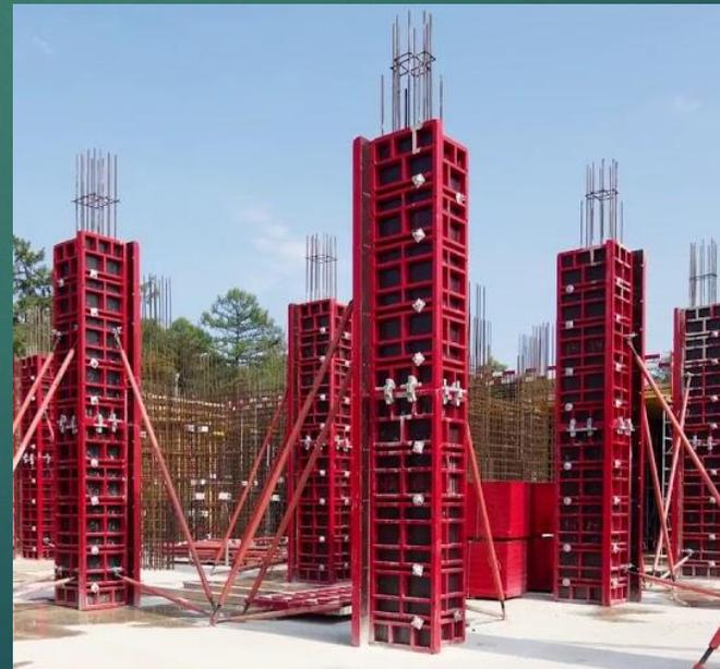
Универсальными щитами можно залить колонну сечением сторон от **200** до **1200 мм** с шагом **50 мм**. Также Универсальные щиты можно использовать совместно с линейными щитами для прямых участков и торцевания стен.
