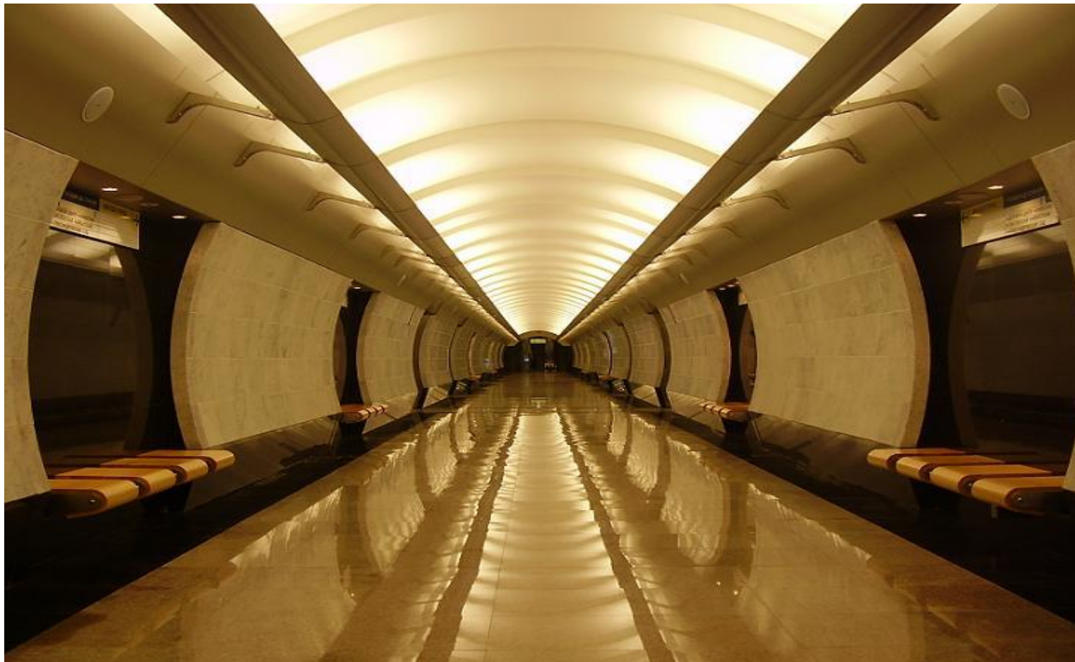
Центральный зал станции
