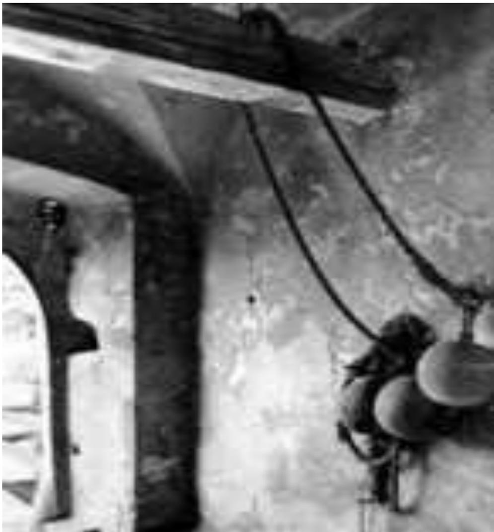
**От моста к подъемным машинам в стенные отверстия уходят канаты или цепи. Для облегчения работы людей, обслуживающих механизм моста, канаты иногда снабжались тяжелыми противовесами, берущими часть веса этой конструкции на себя.**
