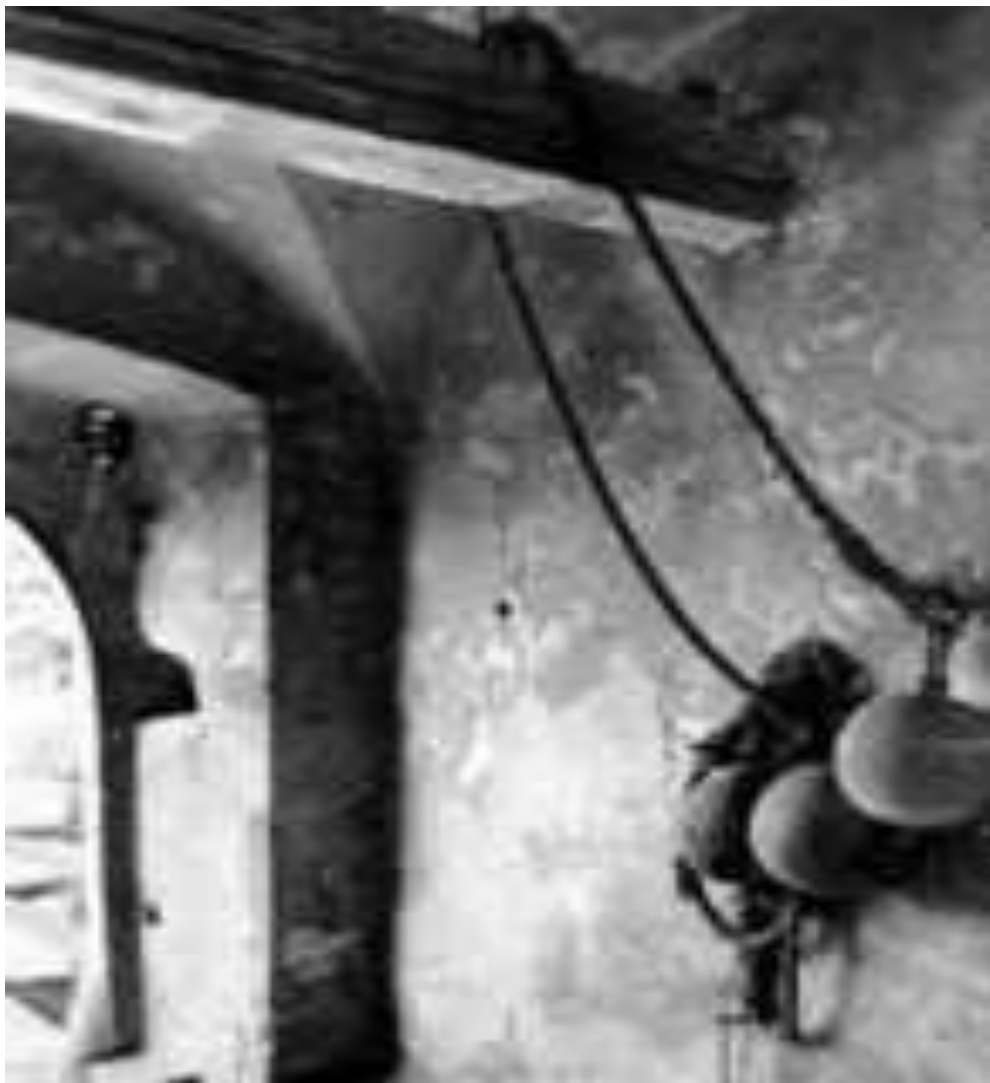
Противовесы на подъемнике ворот
