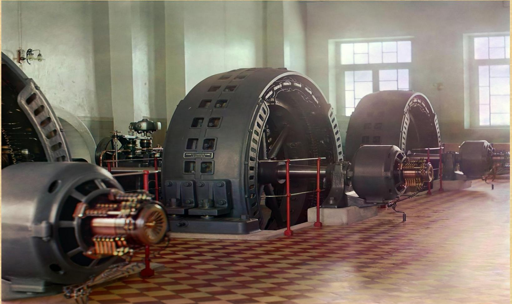
Генератор переменного тока — электрическая машина, преобразующая механическую энергию в электрическую энергию переменного тока. Большинство генераторов переменного тока используют вращающееся магнитное поле. Принцип действия генератора основан на законе электромагнитной индукции — индуцирование электродвижущей силы в прямоугольном контуре (проволочной рамке), находящейся в однородном вращающемся магнитном поле. Или наоборот, прямоугольный контур вращается в однородном неподвижном магнитном поле.
