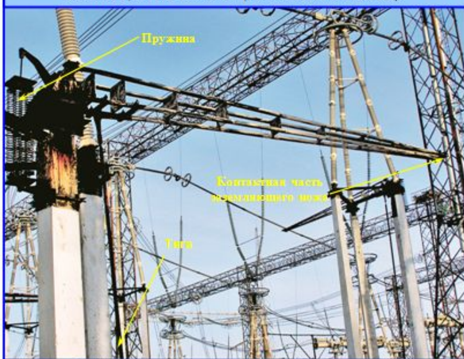
Заземляющий нож ЗР-750-У1 (отключенное положение).
