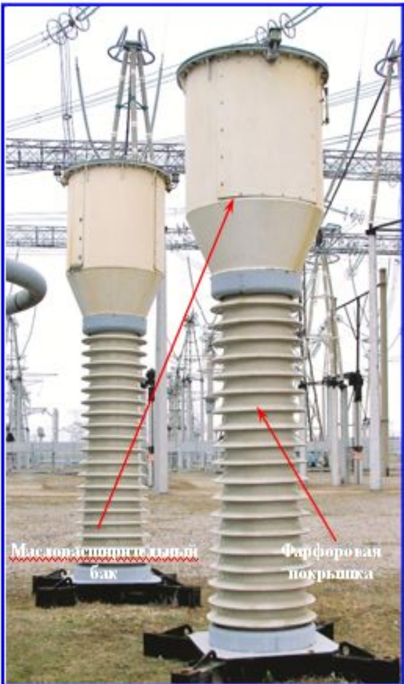
Трансформатор ТФРМ-750 (нижний каскад)
