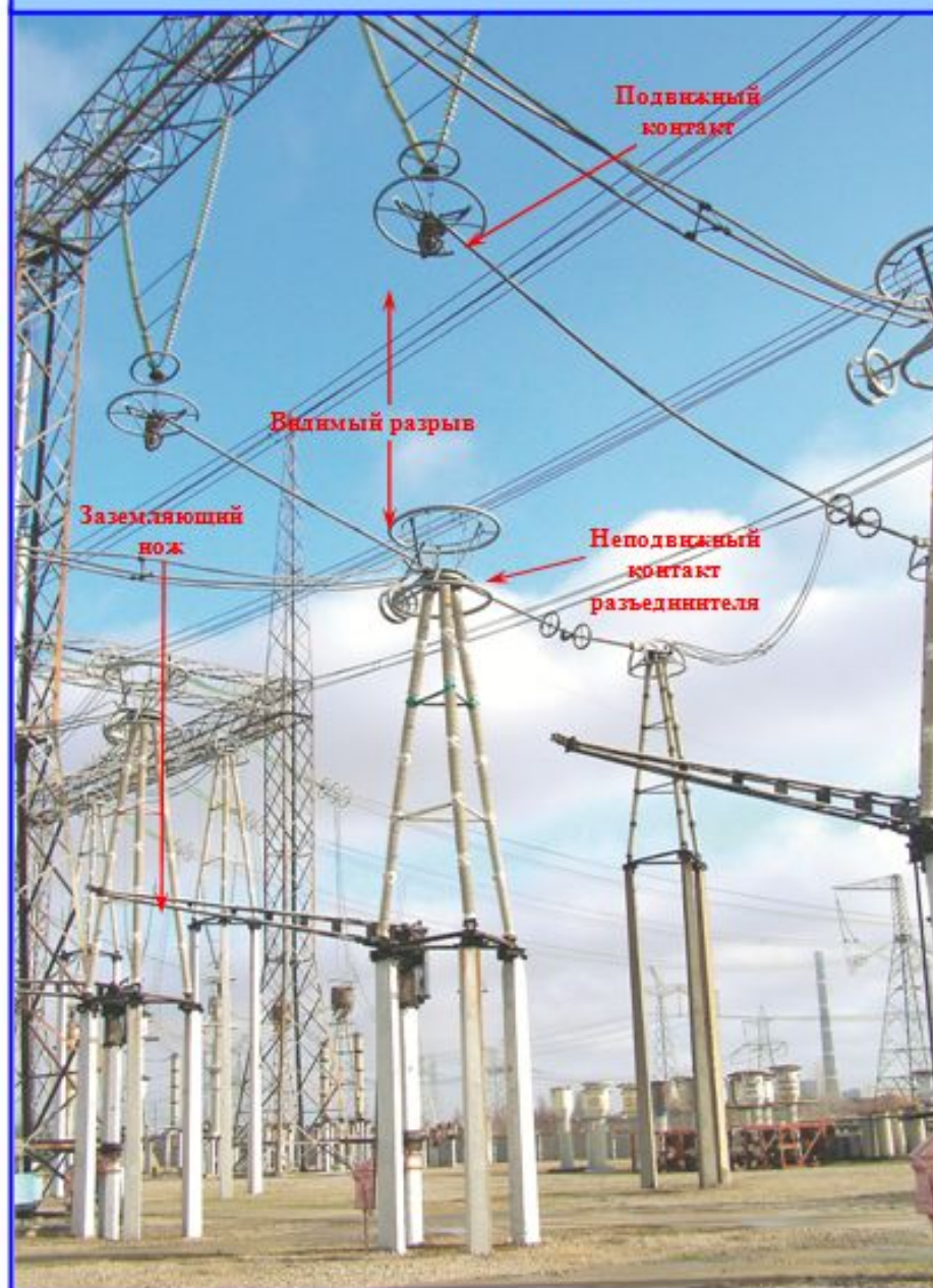
Разъединитель РПД – 750/3150-У1 (Отключенное положение)
