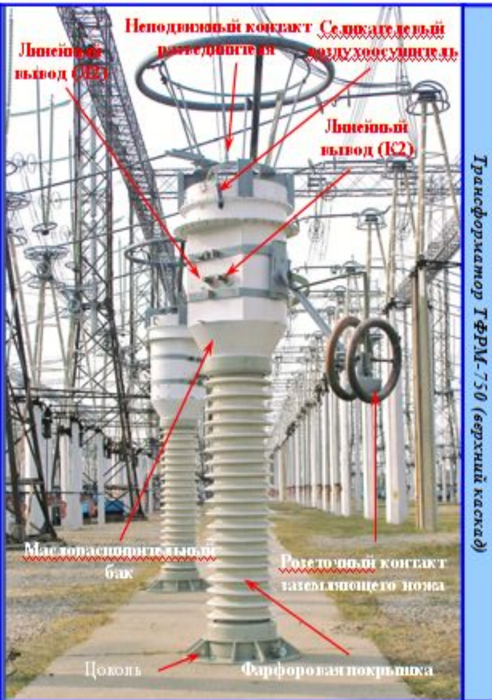
Трансформатор ТФРМ-750 (нижний каскад)
