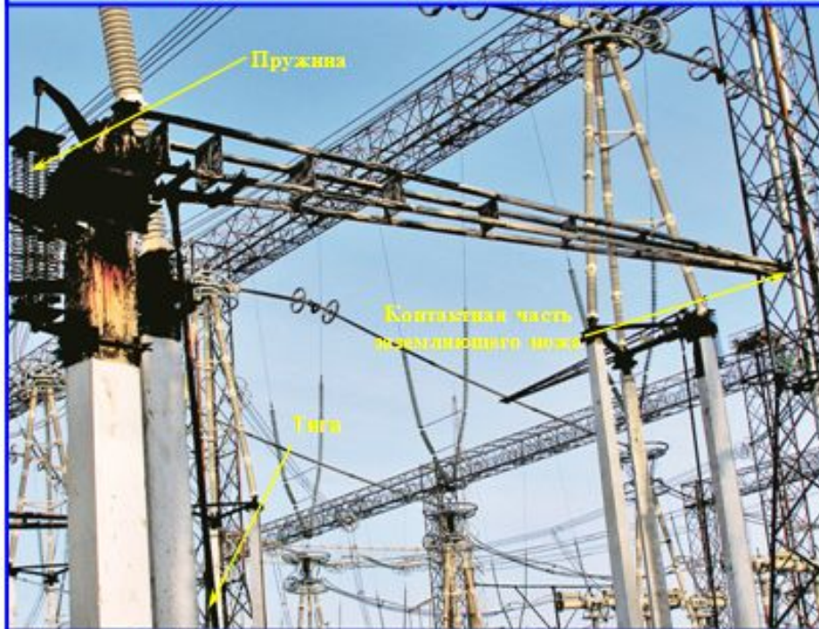
Заземляющий нож ЗР-750-У1 (отключенное положение).
