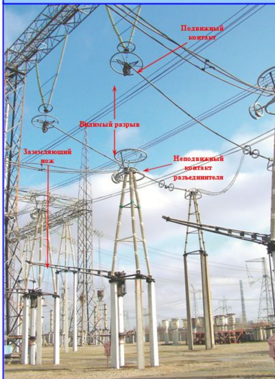
Разъединитель РПД – 750/3150-У1 (Отключенное положение)
