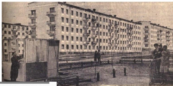
На снимке: улица Садовая.
