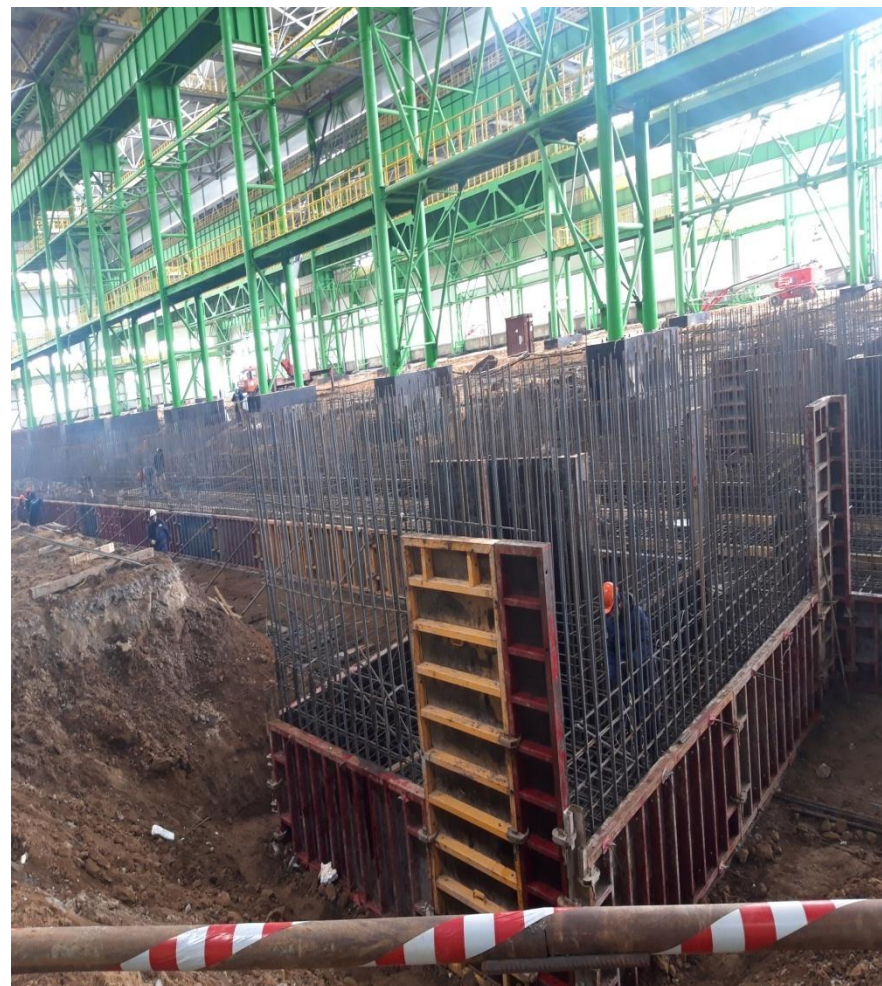
Армирование стен ФОМ16
