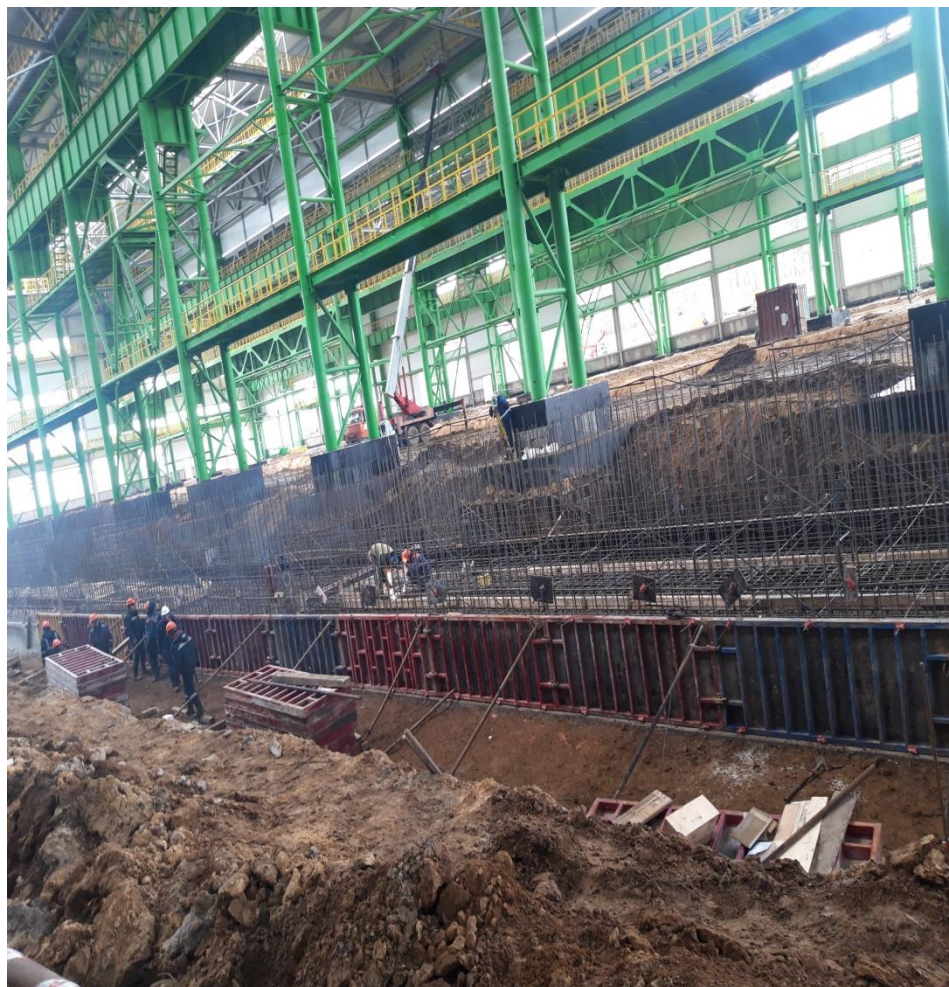
Армирование стен ФОМ16
