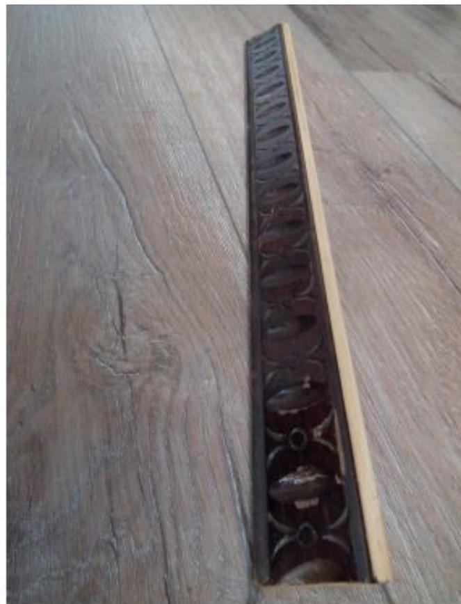
На этой рейке нет больших дефектов. Циклюем и шлифуем эту часть. Заделываем отверстия от гвоздей и маленькие вмятины шпаклевкой. Снова шлифуем.
