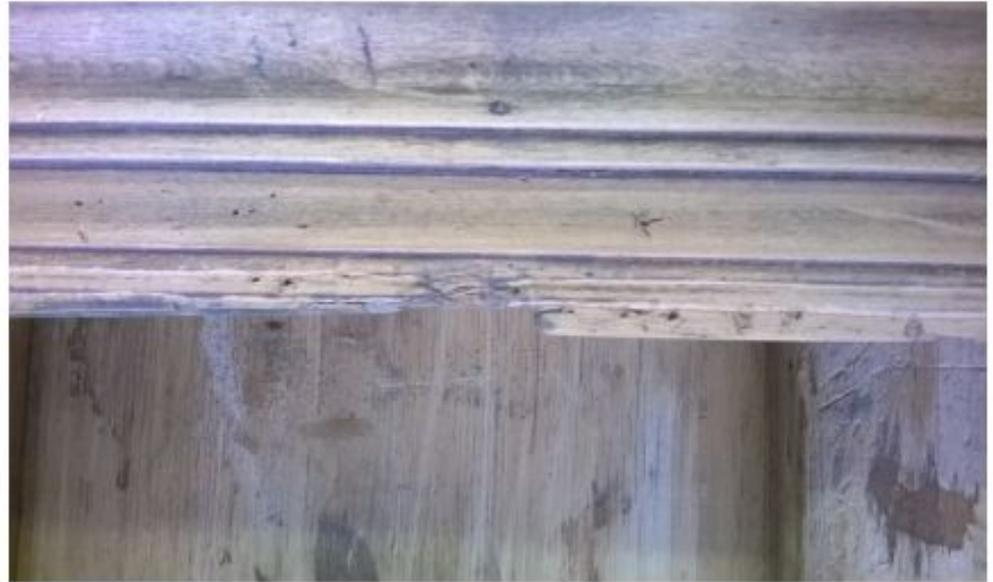
Вставляем заделку в нижний профиль. Размечаем и раскраиваем заготовку из липы. После чего приклеиваем ее на место отсутствующей части профиля и подгоняем под размер стамесками различного диаметра. Шлифуем наждачной бумагой.
