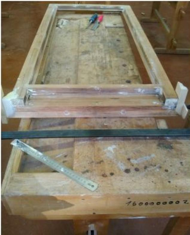
Вырезаем профиля из подготовленного материала. Приклеиваем их на место отсутствия и фиксируем струбцинами. После доделываем некоторые фрагменты шпаклевкой.
