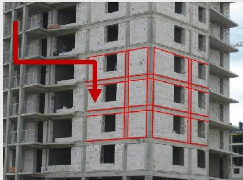
**Простейшая конфигурация здания (в плане прямоугольник) — это когда функцию опор для кровли и перекрытий выполняют стены**
