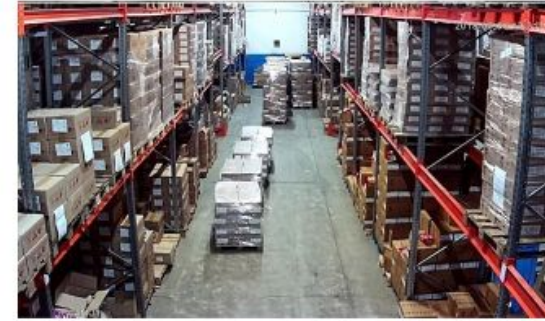
Установка видеонаблюдения на складе
