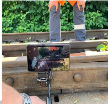
Расширить функционал приложения МРМ ЕКАСУИ\_П возможностью дополнения фото/видео с занесёнными на них отклонениями автоматическим формированием инцидентов (например, рацпредложение по измерению стыковых зазоров, ступеней).
