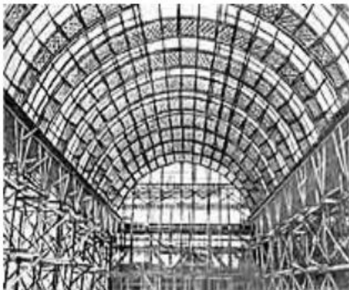
Рибристый свод-оболочка пролётом 100м в момент постройки 1935 год
