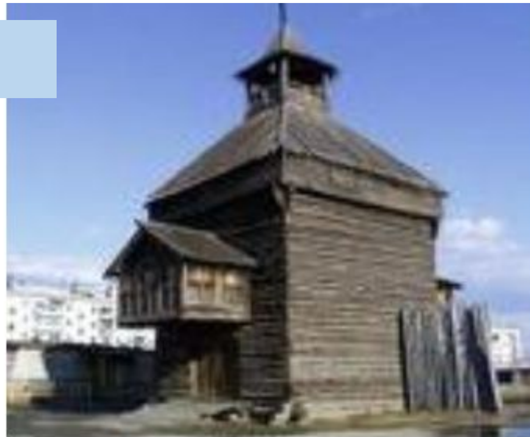
Надвратная башня Якутского острога (1683г)
