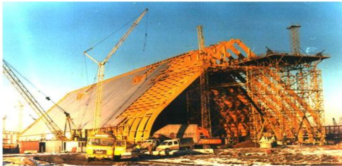
Терминал калийных удобрений Санкт-Петербургского морского порта (пролёт 63 м)
