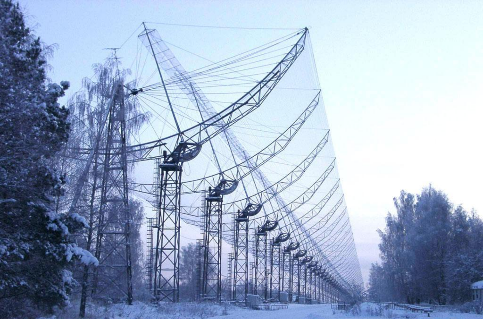
ДКР-1000 Пущино-на-Оке Крест из двух параболических цилиндров 2 x 1000 x 40 м
