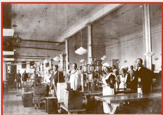
Водочный цех 1901г.
