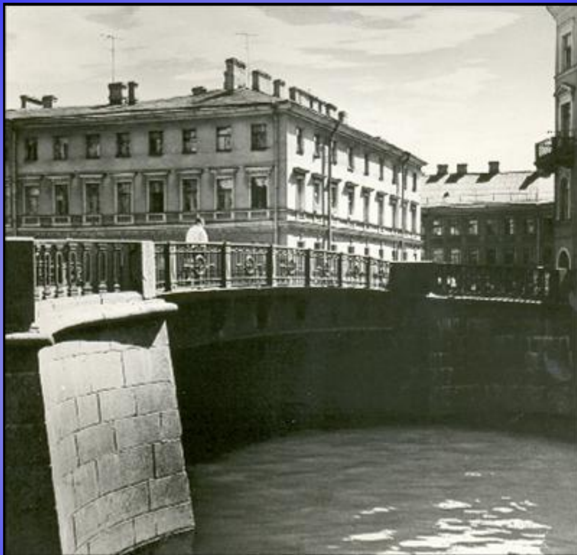
Кокушкин мост через Екатерининский канал (ныне канал Грибоедова)
