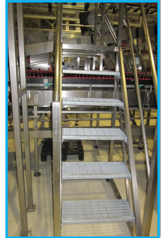
Установка лестницы-перехода между ПЭТ и стекольной линиями
