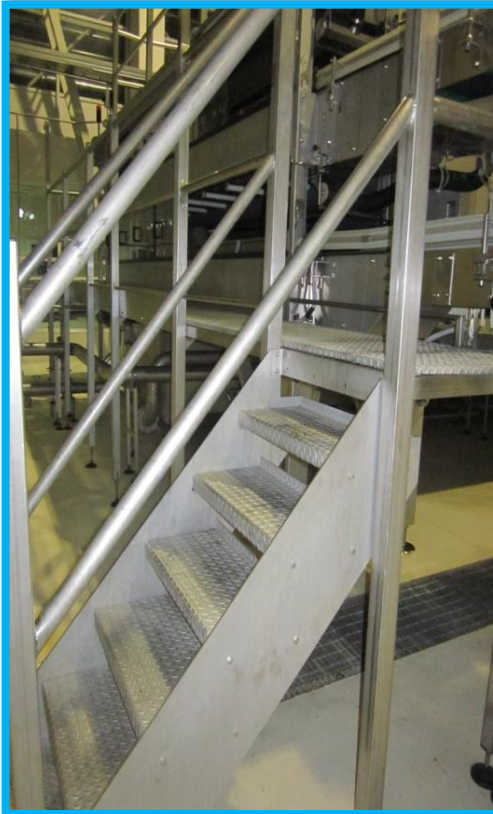
Увеличение площадки для обслуживания пастеризатора баночной линии
