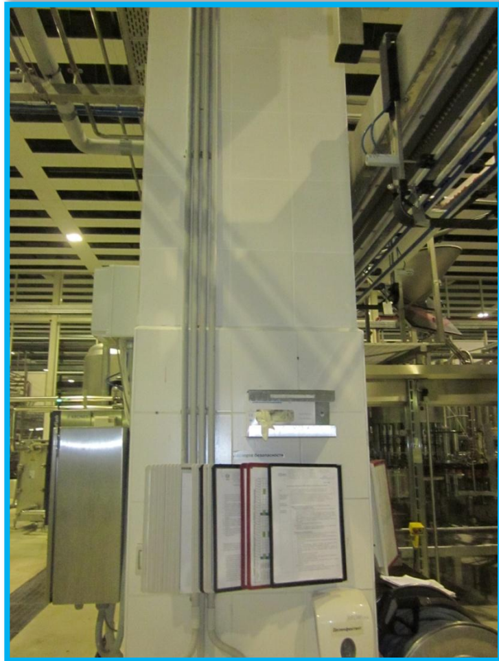
Облицовка плиткой колонн в чистой зоне цеха розлива
