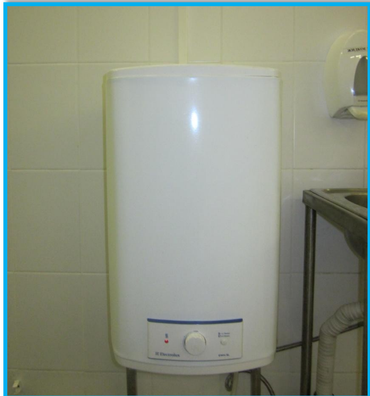
Установка водонагревателя в отделении ГФС
