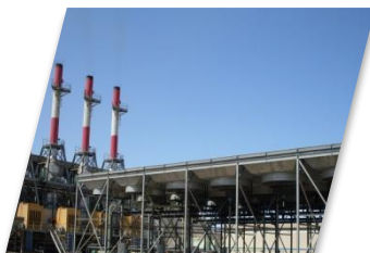
Энергетические станции Cairo, Egypt Guam, Micronesia Berlin, Germany
