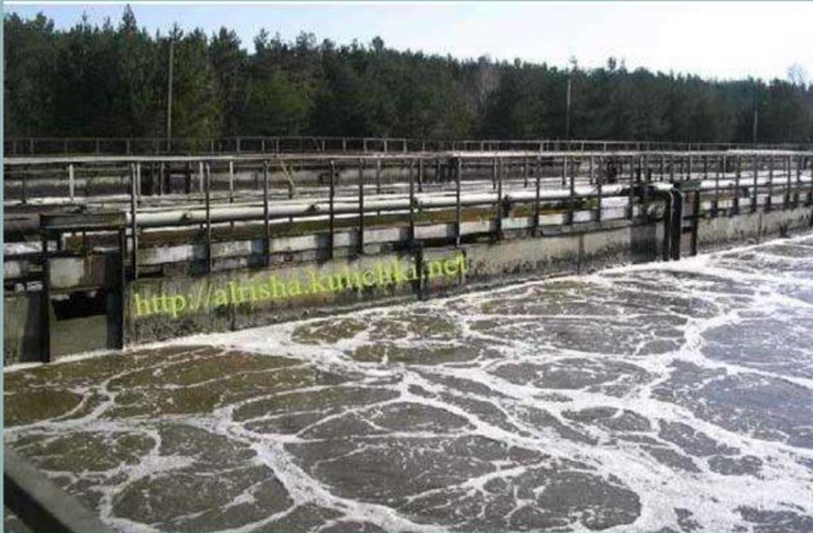
Все аэротенки построены по одному принципу: смесь воды и активного ила медленно движется по резервуарам, непрерывно насыщаясь воздухом. Процесс очистки основан на способности микроорганизмов использовать ЗВ для питания в процессе жизнедеятельности.
