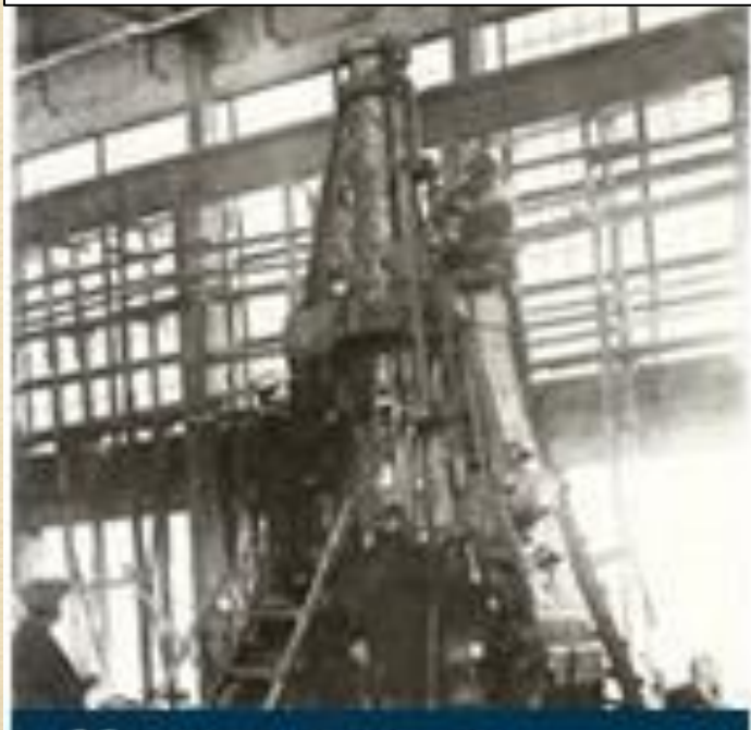
Монтаж молота в кузнечном цехе
