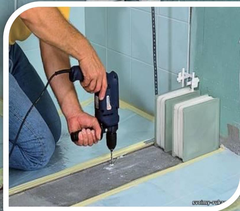
**Крепление шурупом стальной монтажной перфорированную ленту:** Загибают концы ленты и прикрепляют ее к полу, вбивая в просверленные отверстия дюбеля для быстрого монтажа. Используют небольшие дюбеля диаметром 4 мм, длиной 2-3 см, вверху крепят к горизонтальному каркасу.
