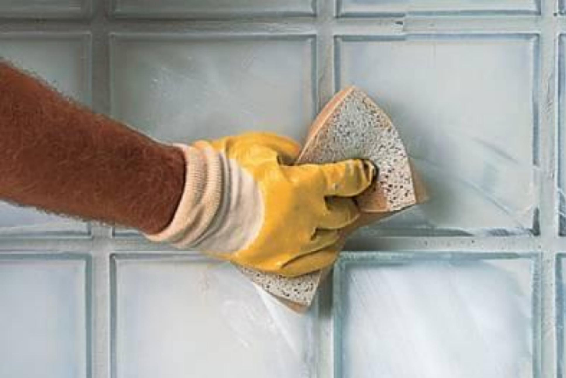
Избыток затирочной массы собираем мягкой губкой, разглаживая швы. Поверхность стенки протирают влажной тряпкой
