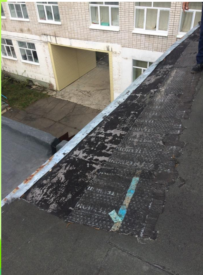
Ремонт кровли 2 корпуса
