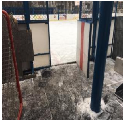
Состояние входных групп
